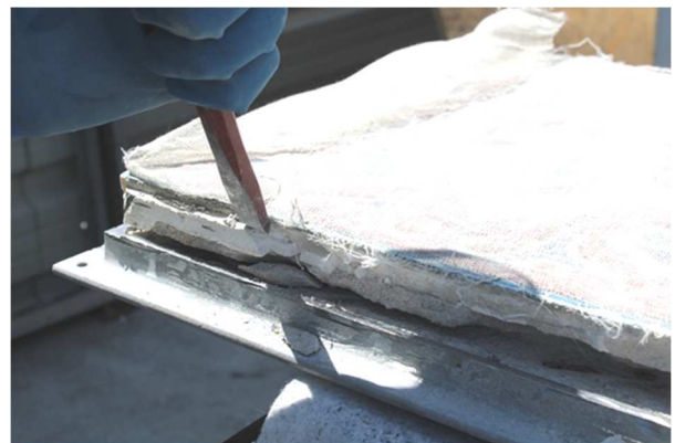
Figura 7 – Remoção manual de argamassa cimentícia e gesso em torno dos azulejos durante a fase de libertação do sistema rígido.
