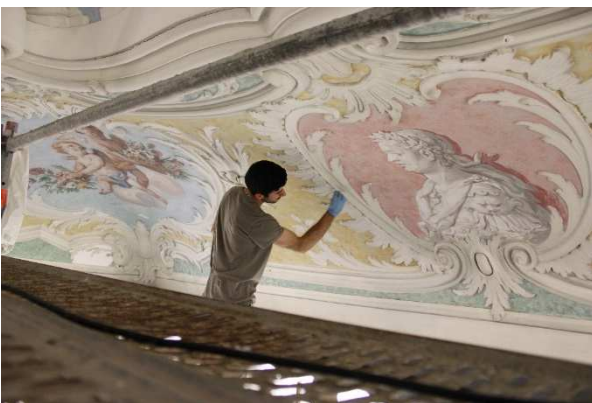
Figura 13 – Limpeza húmida das superfícies com recurso a esponjas de espuma de melamina, ligeiramente humedecidas em água destilada, contribuindo para a melhoria da luminosidade cromática, a definição dos elementos ornamentais em estuque e a sua leitura estética do conjunto.
