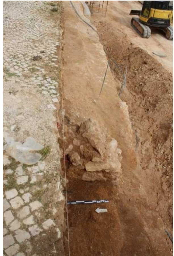
Figura 12 – Vista de plano do muro na área de intervenção.
