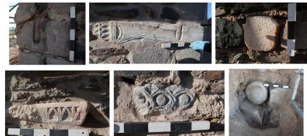
Figura 13 – Pedras reaproveitadas na Torre 7, antiga torre de menagem.
